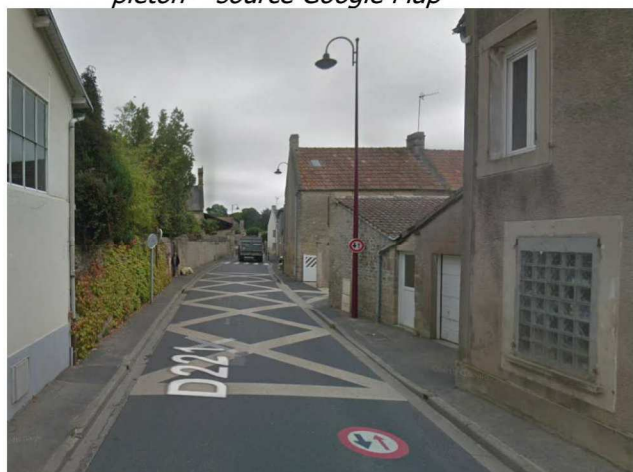
Panneaux et marquages annonçant le rétrécissement de la voirie – source Google Map
